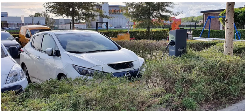
Rys. 7 Przykładowa miejska stacja ładowania w Utrechcie o mocy 22kW [2x11kW]
